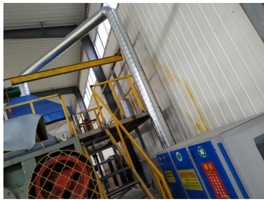
聚氯乙烯防水卷材车间 集气罩+UV 光氧催化
