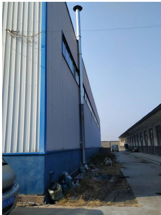
聚氯乙烯防水卷材车间排气筒
